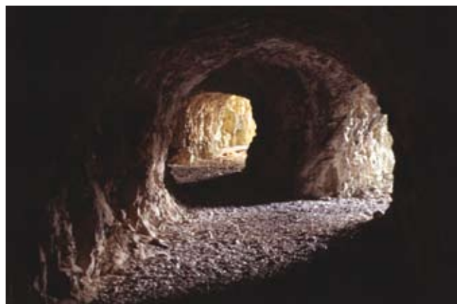
La cannoniera del Brestovec. Vi trovavano alloggiamento otto pezzi situati in un'unica galleria suddivisa in quattro segmenti diversamente orientati (archivio Flavio Cucinato).
